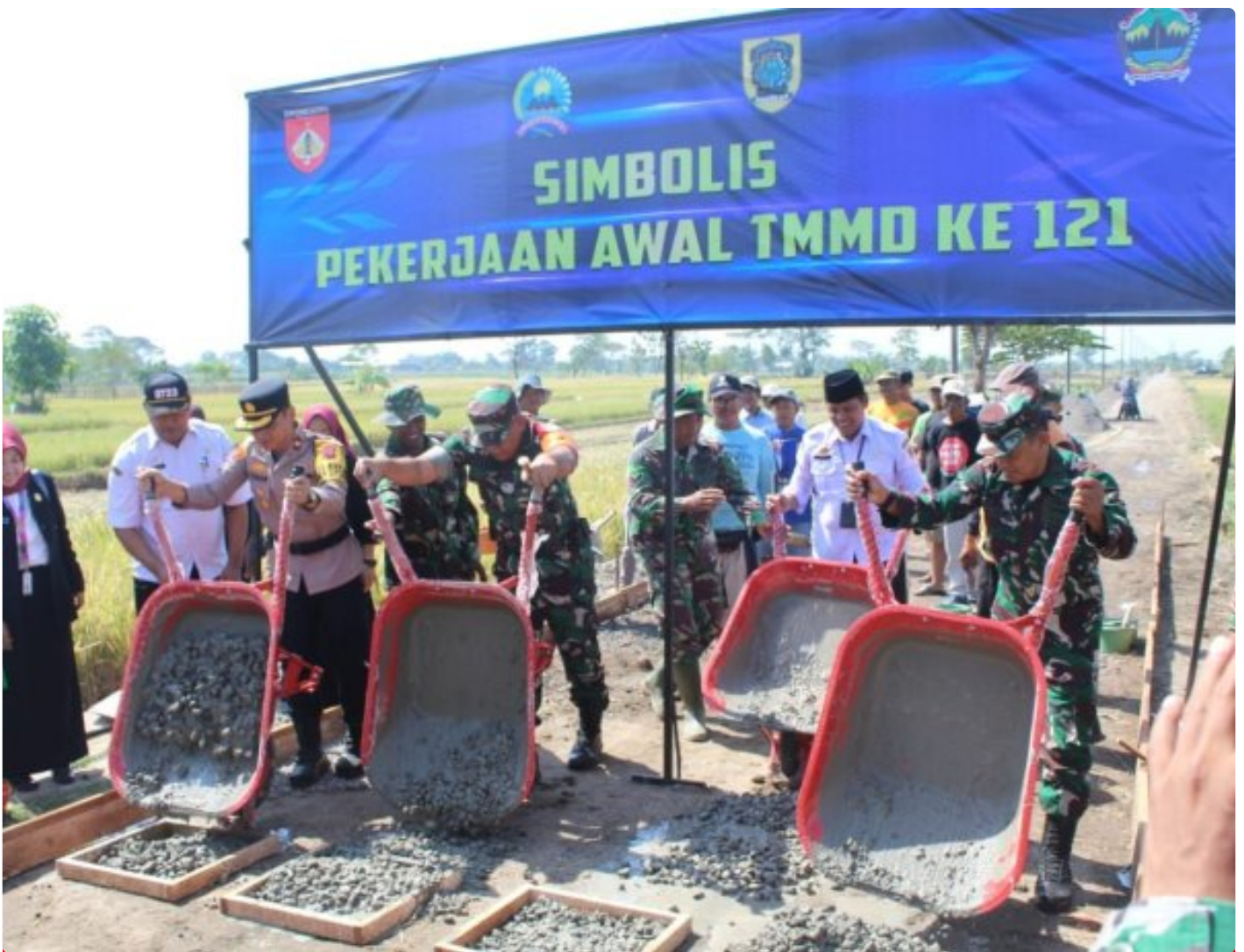
Pengecoran Perdana TMMD Reg 121 dilakukan Forkopimda Klaten
