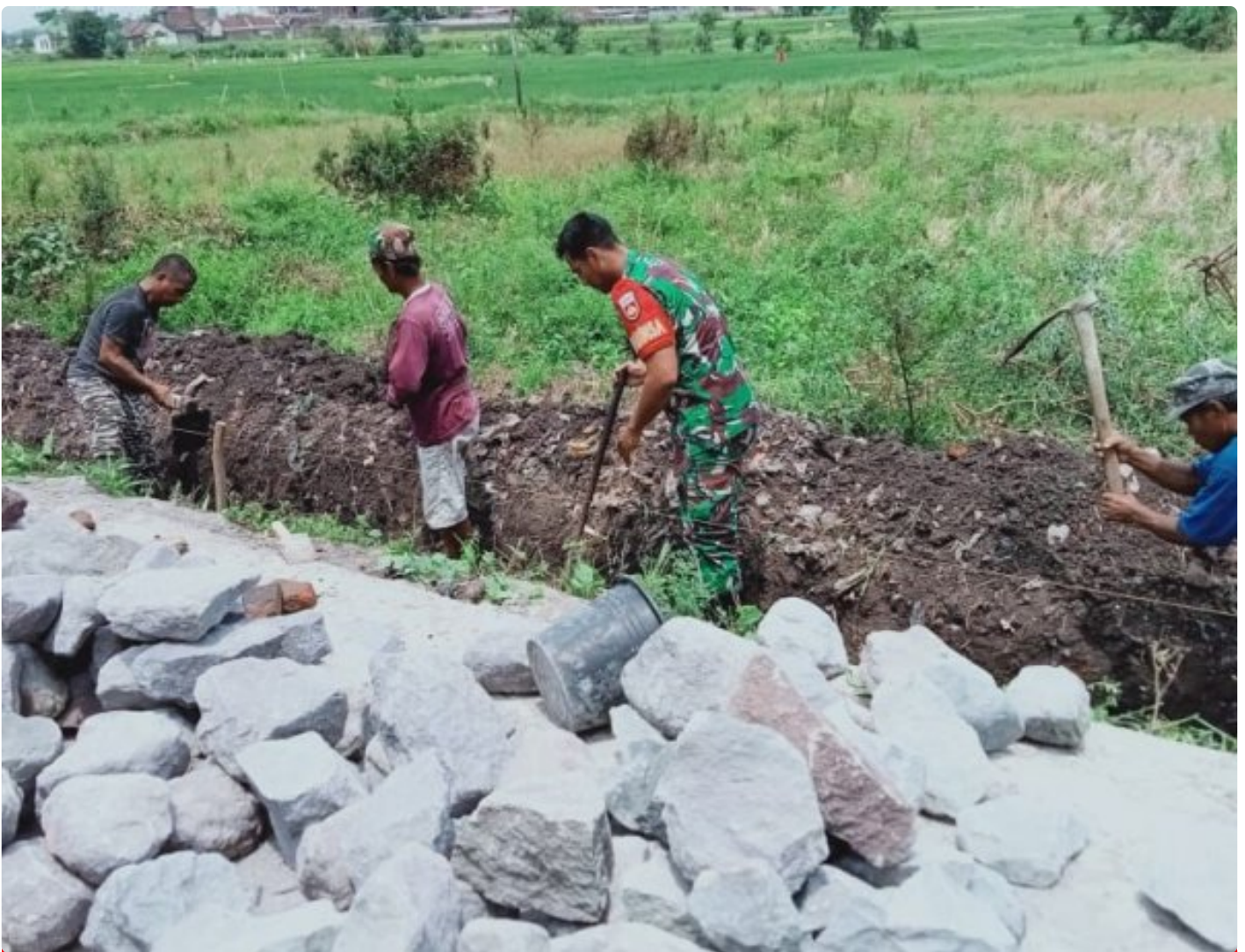
Kemanunggalan TNI Dan Rakyat, Babinsa Wonosari Bantu Buat Talud Desa Binaan
