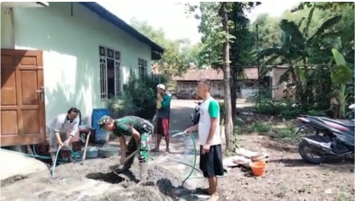
Bantu Kesulitan Warga Babinsa Ceper Cor Lantai Rumah Warga
