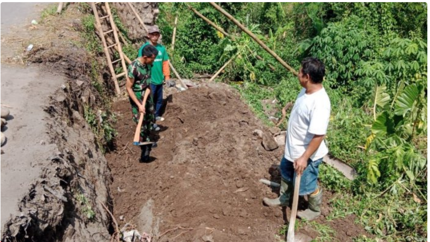
Babinsa Koramil Ceper Bersama Warga Karya Bangun Talud Jalan
