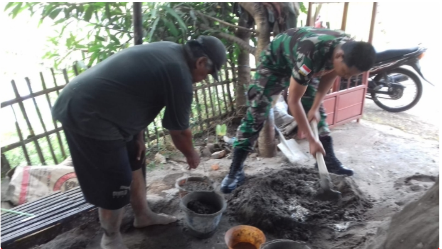
Babinsa Ceper Bantu Warga Renovasi Rumah Binaannya
